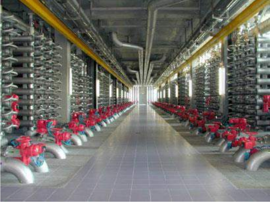
Şekil 7.81 Mery Sur Oise NF su arıtma sistemi içten görünüm (IWA, 2017)
