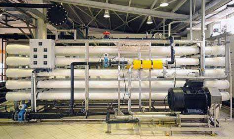
Şekil 7.95 Tesisin genel görünümü (Başaran, 2014)
