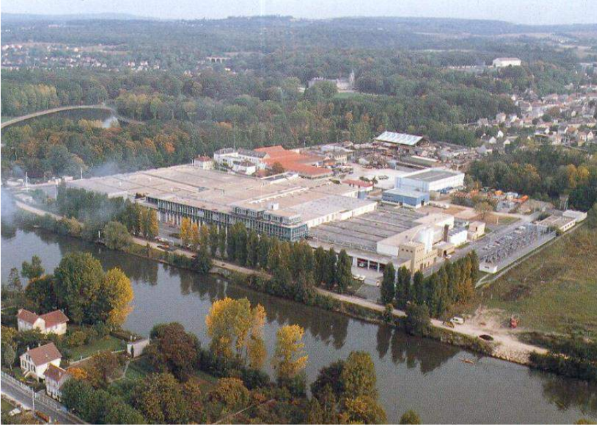
Şekil 7.79 Mery Sur Oise NF su arıtma sistemi dıştan görünümü
