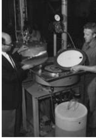
Şekil 6.1 Professor Sidney Loeb ve mühendis Ed Selover plaka ve çerçeve modülden çıkarttıkları ters osmoz membranını incelerken. (UCLA Engineering, 2009)
